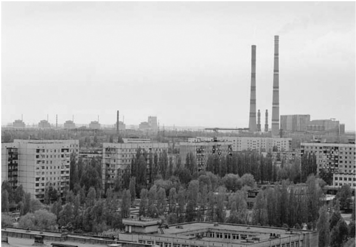
Рис. 13. Труби Запорізької ДРЕС. Фото з власного архіву
